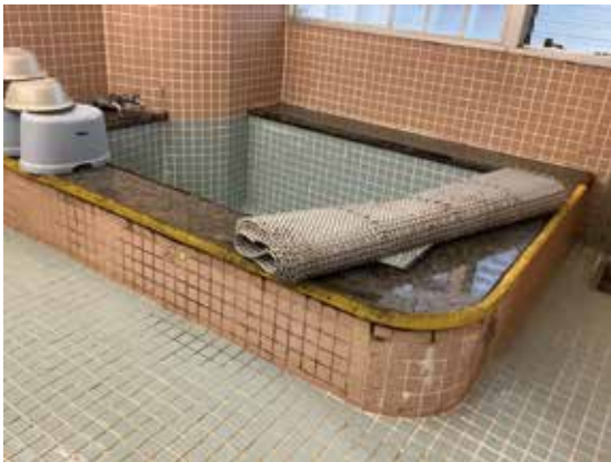
写真3 改修前の浴室
