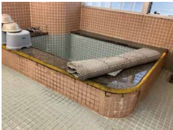
写真3 改修前の浴室
